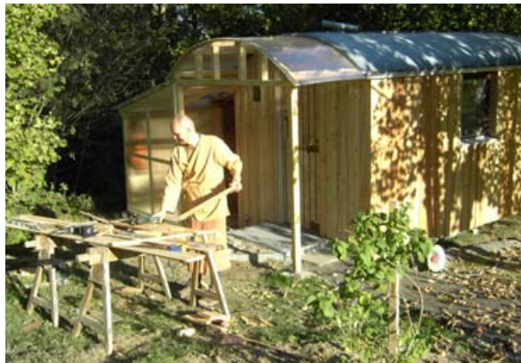
Bhante Sambodhi beim Ausbau des Bauwagens
